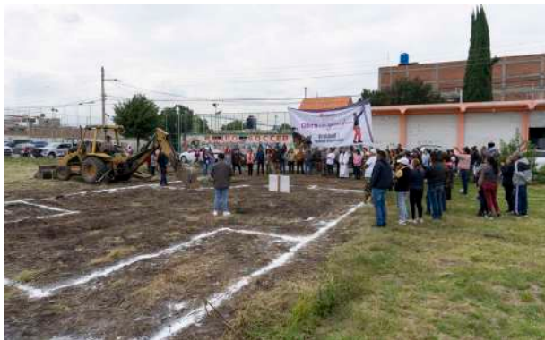
Construcción de casa del adulto mayor en la comunidad de Huitznahuac, municipio de Chiautla. / 2,385 beneficiados
