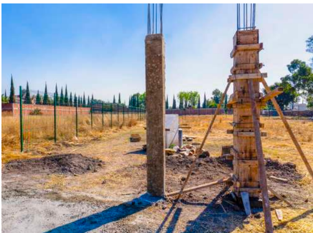
Construyendo instalaciones en apoyo para las comunidades del municipio.
