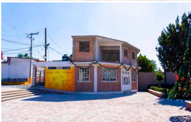
Construyendo instalaciones en apoyo para las comunidades del municipio.
