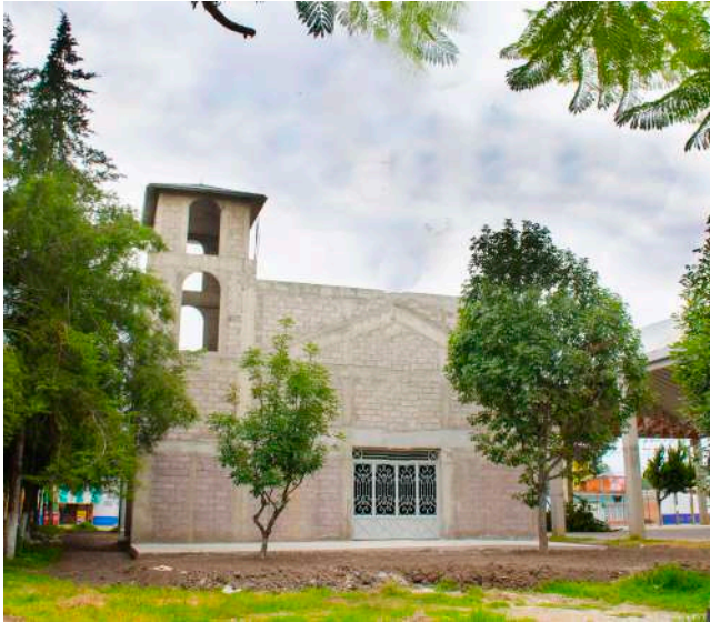
Construyendo instalaciones en apoyo para las comunidades del municipio.
