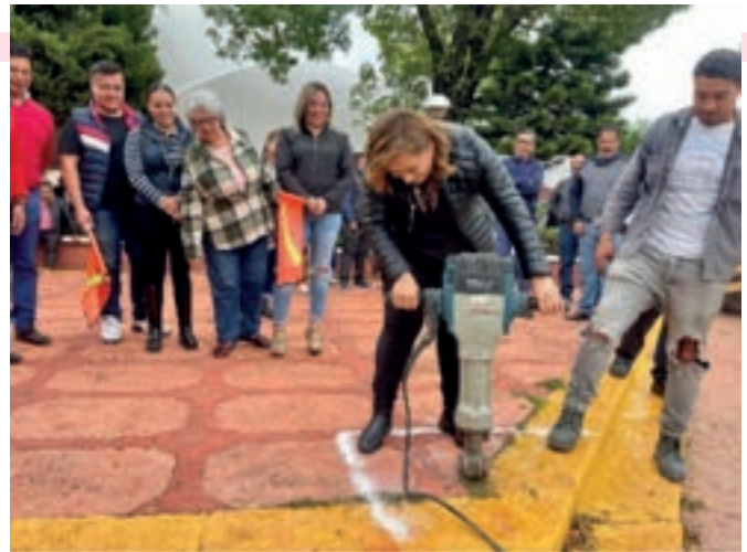
Construcción de explanada en centro comunitario San Juan. 1,500 habitantes / Inversión: $ 830,000.00
